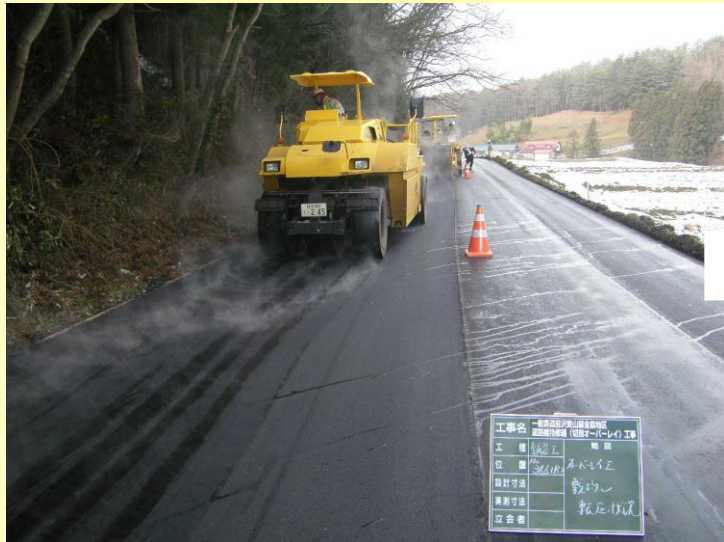
年末に完了した2工区の施工状況 (アスファルトを締固めている状況です。)
