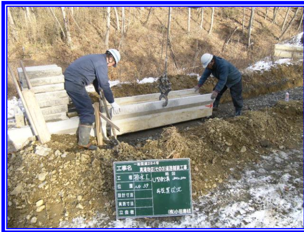
落蓋式U型側溝再設置状況
