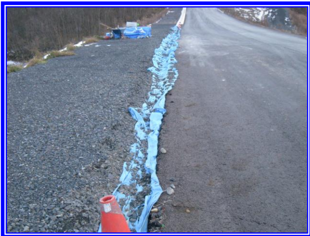
歩車道境界ブロック撤去箇所 (再設置箇所をシートで養生中)
