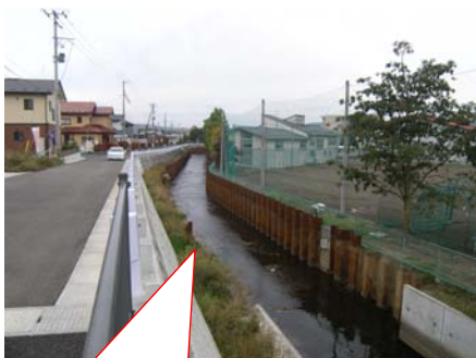
工事着手前の状況です。 (22年10月)
