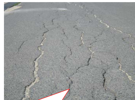
今後は、地震と工事により 傷んだ舗装の復旧工事を 実施させて頂きます！
