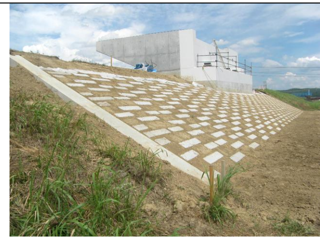
左岸側のA1 橋台(護岸ブロック設置完了)
