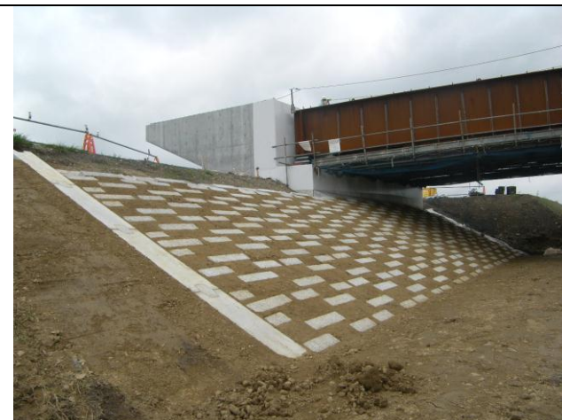
右岸側のA2 橋台(護岸ブロック設置完了)
