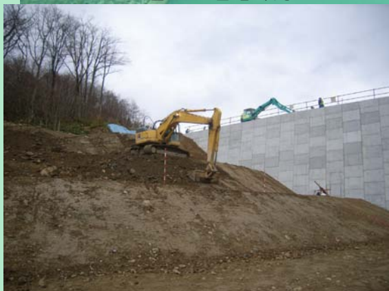
土砂斜面の形を整えています
