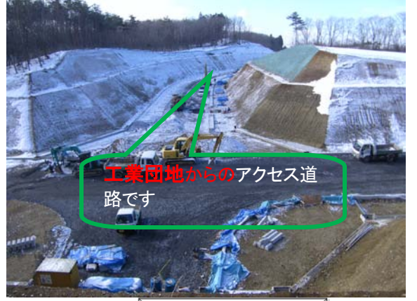
工業団地に通じる市道工事
