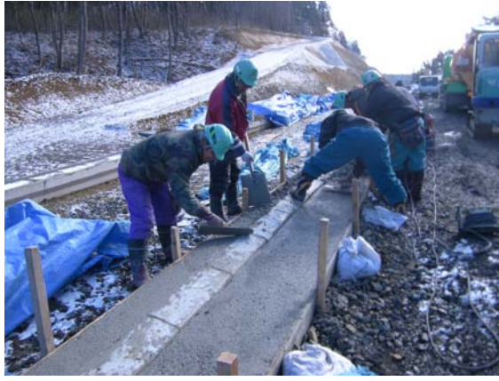
L型側溝の打設作業(写真②)
