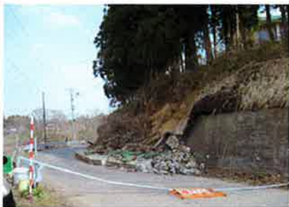
旧107号立花地区交流センター 下側の道路
