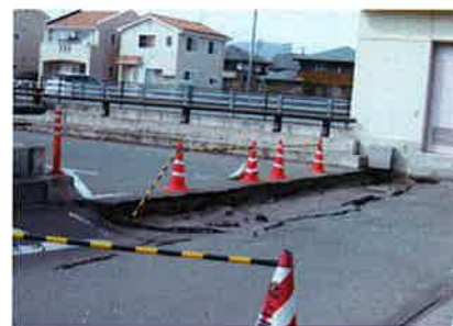
上川原常盤台線側道JR近接部その1
