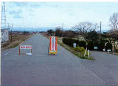
和賀川堤防線
