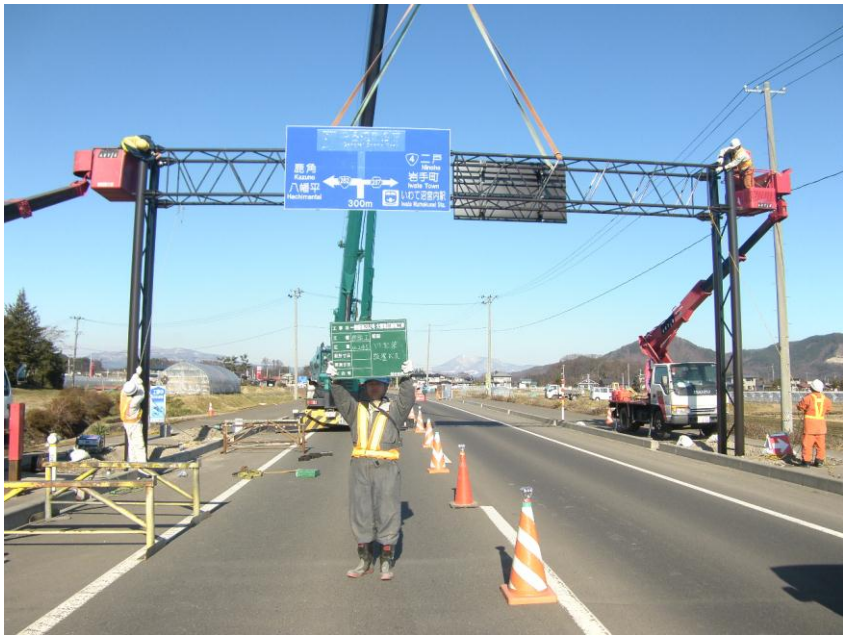
大型標識施工状況
