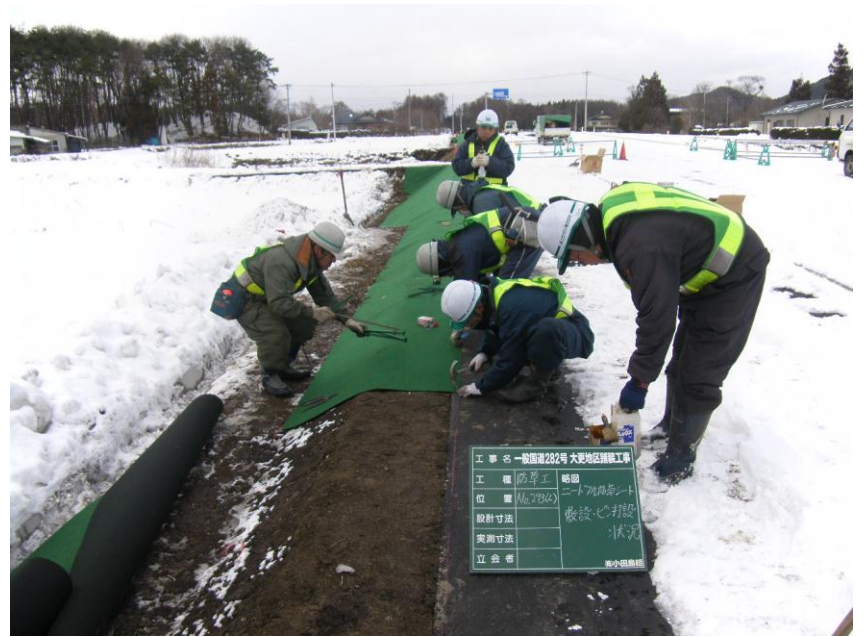
防草シート敷設状況
