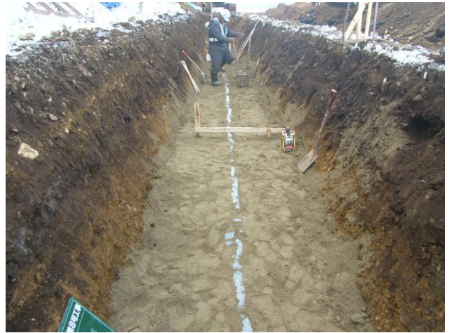
山砂による埋戻し（撒き出し）状況
